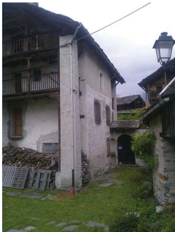
Fig. 1, l'edificio del borgo di Quare di Campertogno, su cui appare l'affresco
