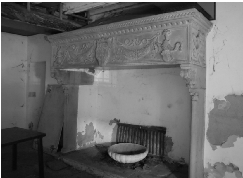
Fig. 20 Camino quattrocentesco ancora esistente in un locale al piano terreno
